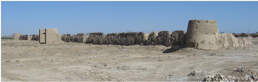
تصویر ۶- قلعه اربابی ظهیرآباد در غرب محوطه دولت‌آباد قدیم؛ دید از جنوب به شمال (نگارنده)
