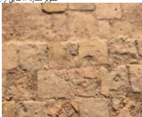
تصویر شماره ۸: نمایی از آجر فرش سقف کاروانسرا عکس از نگارنده
