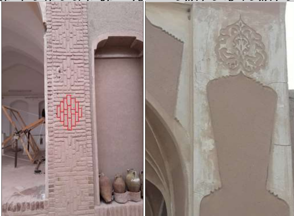
تصویر (۱۴) تزئینات گچی درگاه ورودی ضلع شمالی تصویر (۱۵) تزئینات آجرکاری ایوان شرقی (نگارندگان، ۱۳۹۷)
