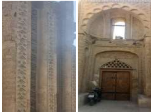
شکل ۱ نمای سردر مسجد جرجیر جزرهای بیرونی سردر
