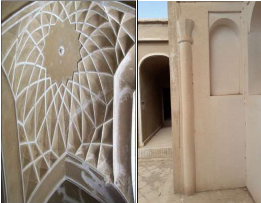
تصویر (۲۹) ستون گچی دوطرف ایوان شرقی (نگارندگان، ۱۳۹۷) تصویر (۳۰) تزئینات رسمی بندی سقف ایوان غربی (آرشو میراث فرهنگی خوسف)
