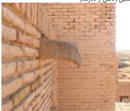
تصویر شماره ۹: نمایی از ناودان سنگی کاروانسرا (عکس از نگارنده)
